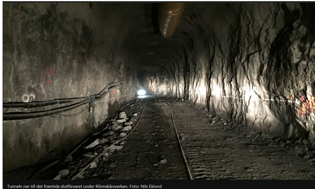
Tunneln ner till det framtida slutförvaret under Rönnskärsverken. Foto: Nils Eklund
