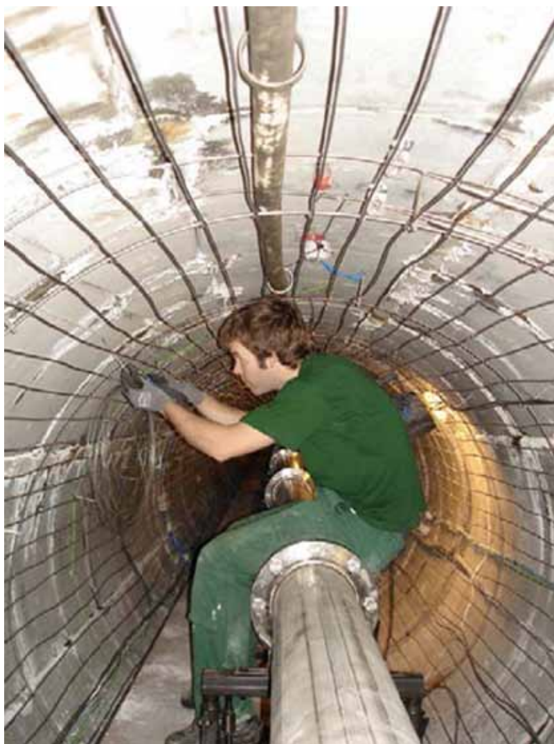
Installation av fiberoptiskt övervakningssystem i ett av MoDeRns projekt.
